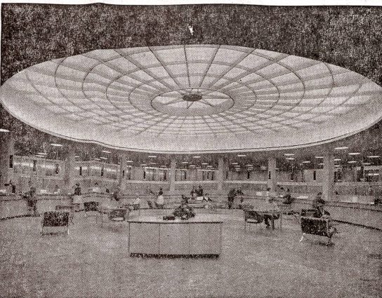
Blick in die Schalterhalle des Neubaus des Schweizerischen Bankvereins
