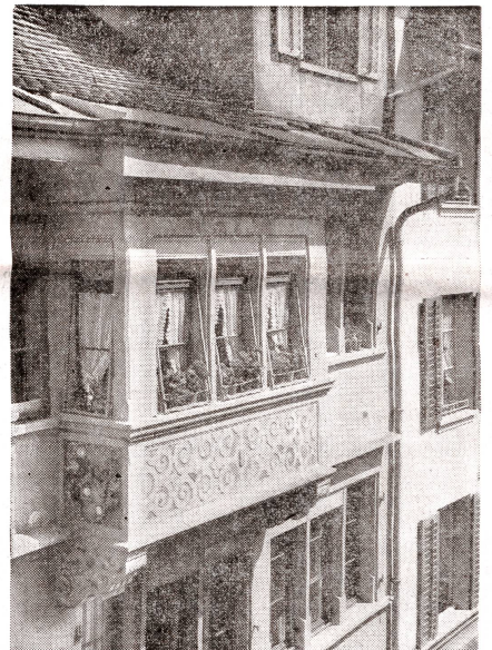
Kirchgasse 27, Haus zur Engelburg; Fenstererker um 1600
