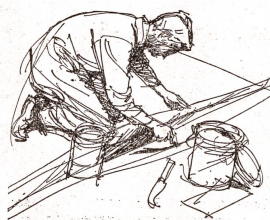
Linoleumleger beim Kleben des Bodenbelages. (Köllä)
