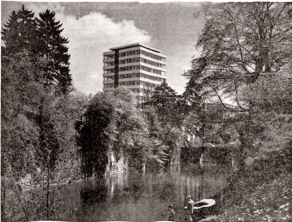
Das Hochhaus «Zur Schanze» am Schanzengraben. Bauherr: Baukonsortium «Zur Schanze», Zürich. Ausführung der Maurer- und Eisenbetonarbeiten: AG. Heinr. Hatt-Haller, Zürich.
