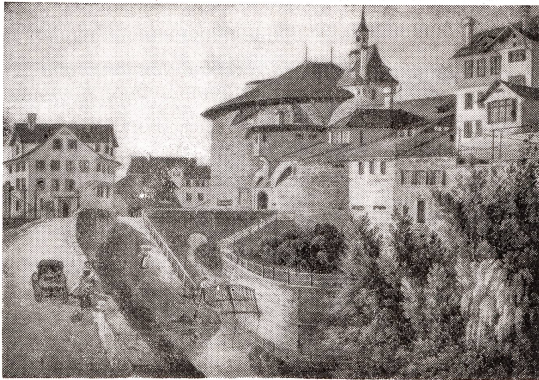
Steinbrücke zum ehemaligen Rennwegbollwerk, abgebrochen 1865, nach Aquarell von J. J. Meier, 1835
