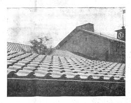
einzelne Ziegel beschädigt werden, sind sie rasch ausgewechselt.
