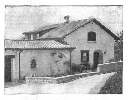
überflüssig und erlaubt somit eine schuppenartige Eindeckung mit kleinen Elementen, zum Beispiel Dachziegeln. Bei Gebäudesenkungen oder Bewegungen des Dachstuhls vermag sich die Dachhaut anzupassen. Kleine nicht starr verbundene Elemente machen die Bewegung mit. Das Dach bleibt dicht. Die Unterhaltskosten bedeuten bei einem Ziegeldach kein Problem. Sollten durch Schneedruck oder bei der Begehung des Daches
