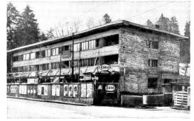
Baute zwei Rampen als Ein- und Ausfahrt. Damit wird eine Drehscheibe zugunsten einer raschen Bedienung ersetzt. Die beiden Obergeschosse erhalten acht individuell organisierte Wohnungen mit eingesetzten Balkonen.
