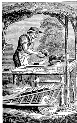
Durch ein Strohdächlein vor der Sonne geschützt, formte der Handziegler im Freien seine Mauersteine, die er dann am Boden zum Trocknen aufschichtete.
