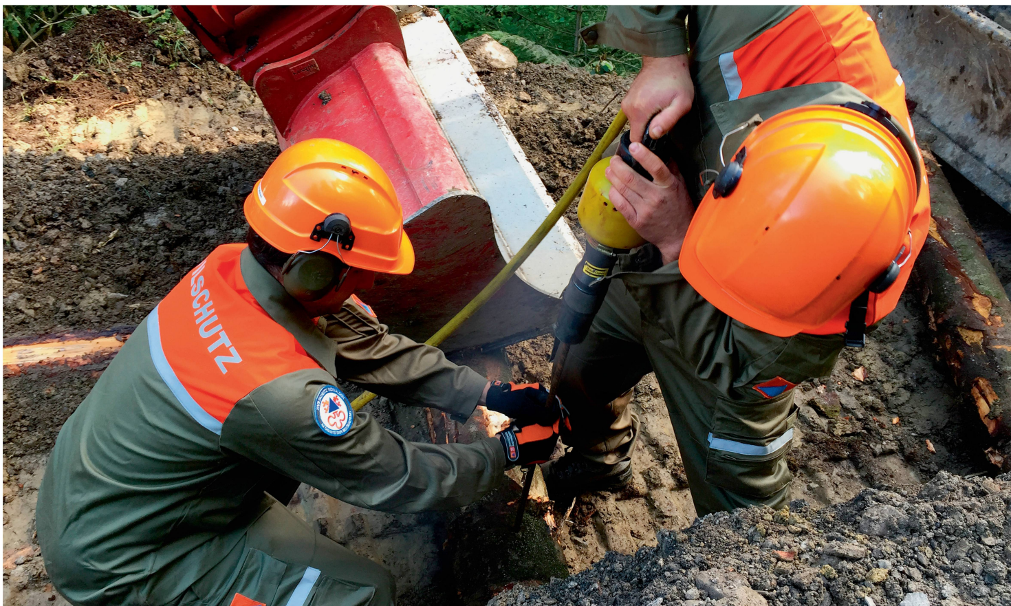
Instandstellungsarbeiten sollen neu als Ausbildung gelten und als Wiederholungskurse geleistet werden. Im Bild: Pioniere der Zivilschutzorganisation Nidwalden verschrauben Holzstämmen mit Armierungseisen.
