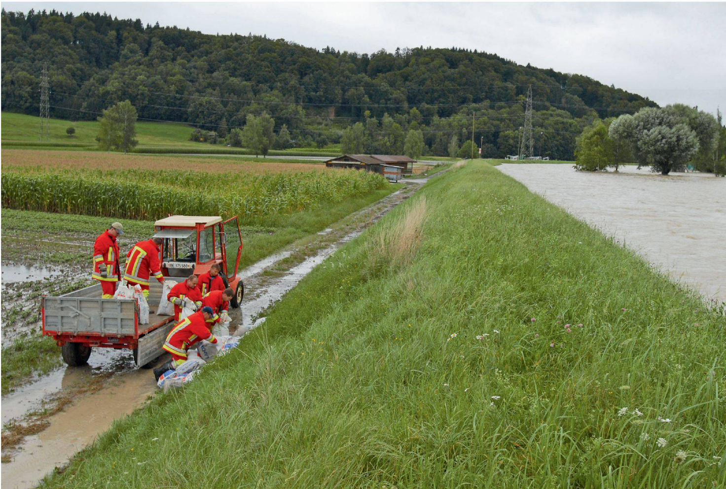
Insbesondere bei Hochwassern, die mehrere Kantone betreffen, ist ein rascher Informationsaustausch zwischen den Führungsorganen sehr wichtig. Im Bild: Hochwasser 2007 im Kanton Bern.
