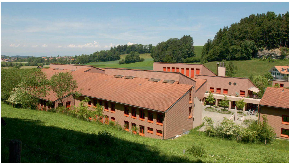
Erste Ausbautetappe des Eidgenössischen Ausbildungszentrums in Schwarzenburg.
