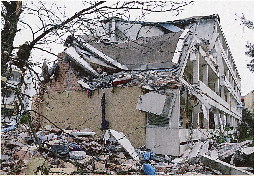
Auswirkungen der Explosion auf die Liegenschaft.
