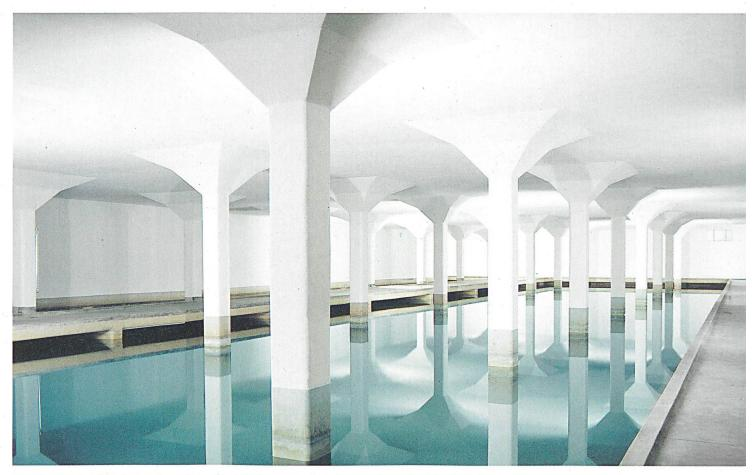
In der Seewasseraufbereitungsanlage Lengg sickert das Wasser durch die horizontal eingelegte Sandschicht.
