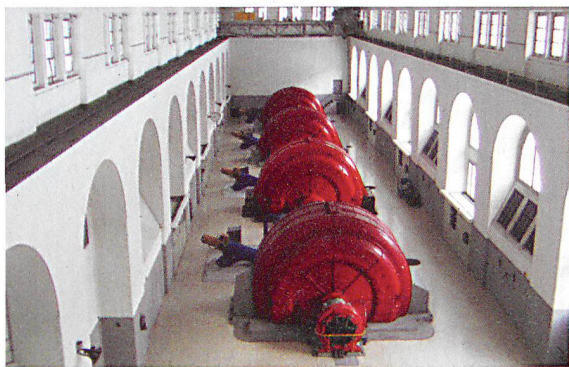
Generatoren des SBB-Kraftwerks in Amsteg.
