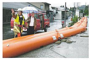
Um auf 1000 Metern den gleichen Schutz wie mit dem mobilen System zu erreichen, wären rund 75000 Sandsäcke nötig.
