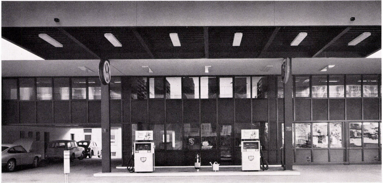
Vordachkonstruktionen und Metallfassaden
