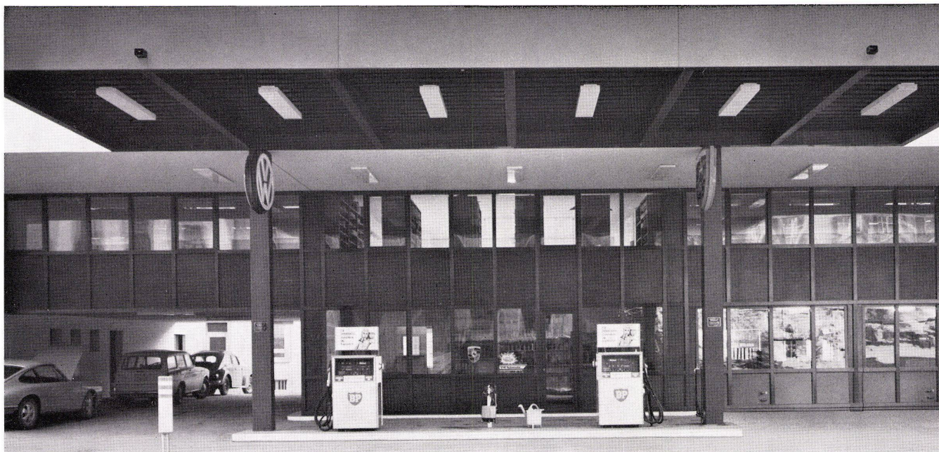
Vordachkonstruktionen und Metallfassaden
