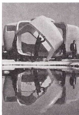
2 Transport der Teile. Die Dimensionen der Teile wurden so gewählt, daß der Straßenverkehr nur wenig behindert wird.
