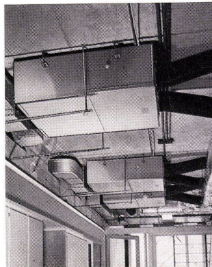
3 Zweikanal-Hochdruck-Klimaanlage mit Mischgeräten. 4 Einkanal-Hochdruck-Klimaanlage mit Entspannungsgeräten. 5 An der Flurdecke angeordnete Mischgeräte.
