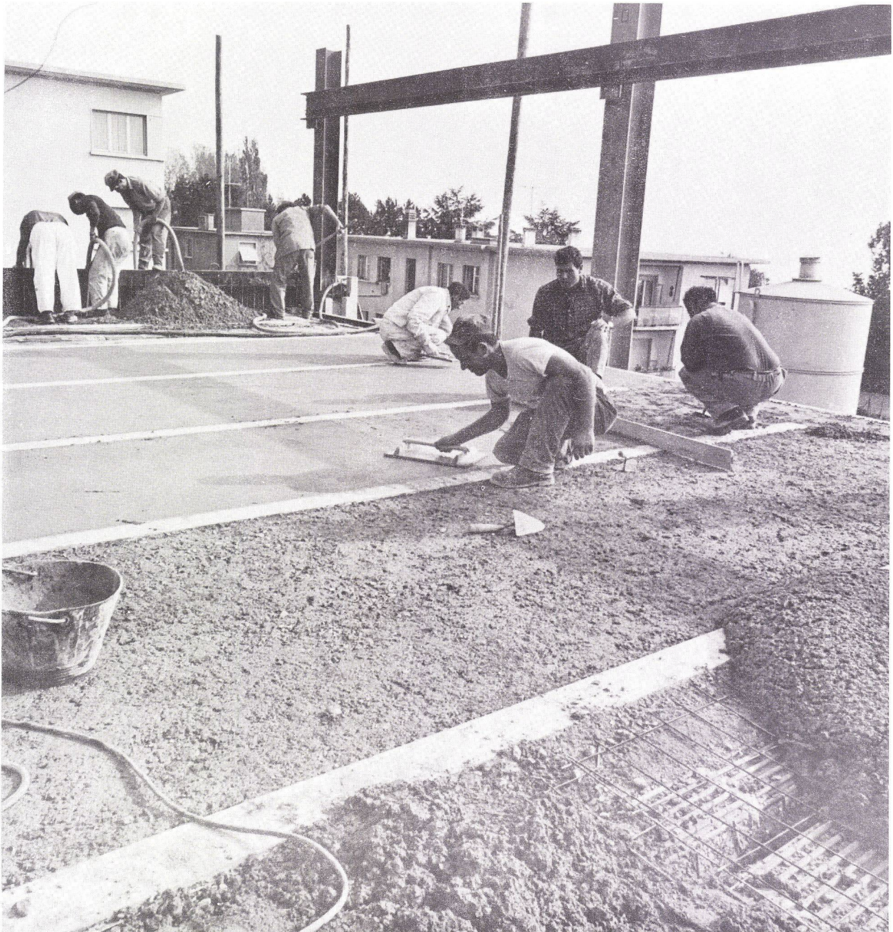
3) LISSAGE DE LA CHAPPE SAEUBERUNG DES UEBERBETONS
