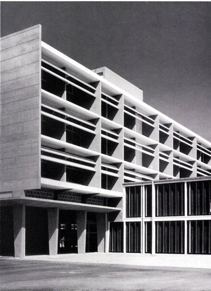
1 Hauptklassengebäude. Ansicht von Nordosten mit waagrecht Sonnenblenden.
