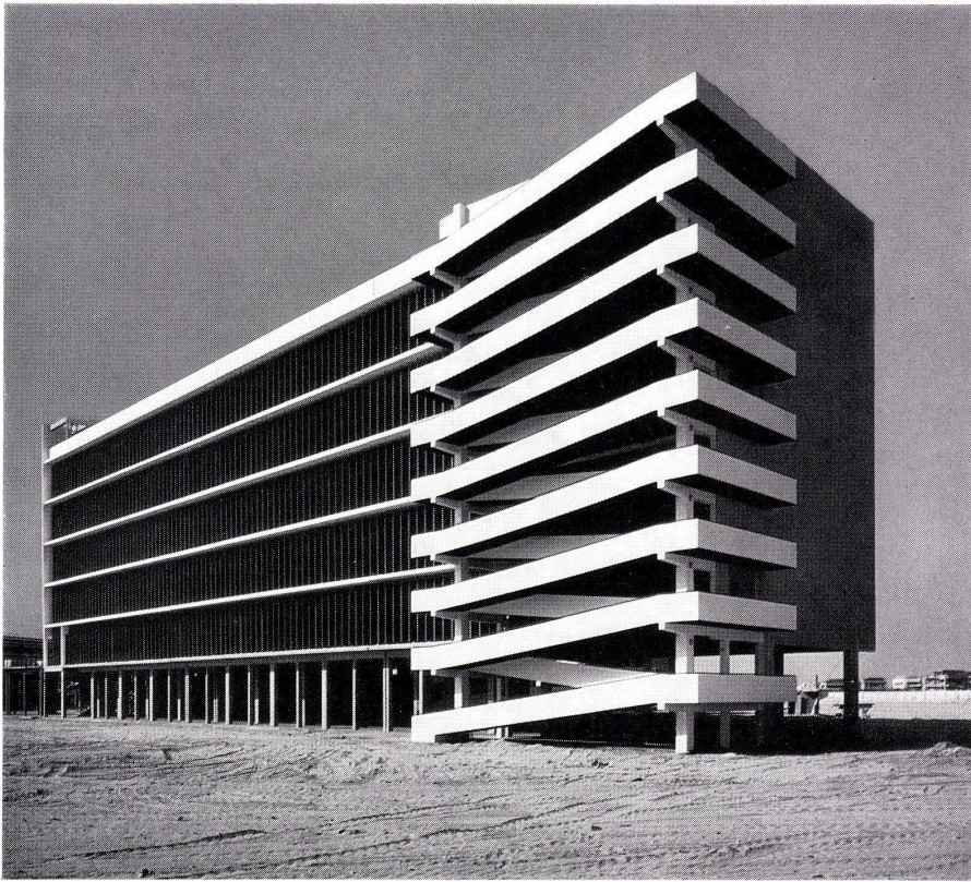
Schülerinnendormitorium, Ansicht von Südosten mit senkrechten Sonnenblenden und Geschößrampen. Dortoir des écolières, vu depuis le sud-est (brise-soleil verticaux) et rampes. Pupil's dormitory, seen from the south-east (sun-breaks are vertical) and ramps.
