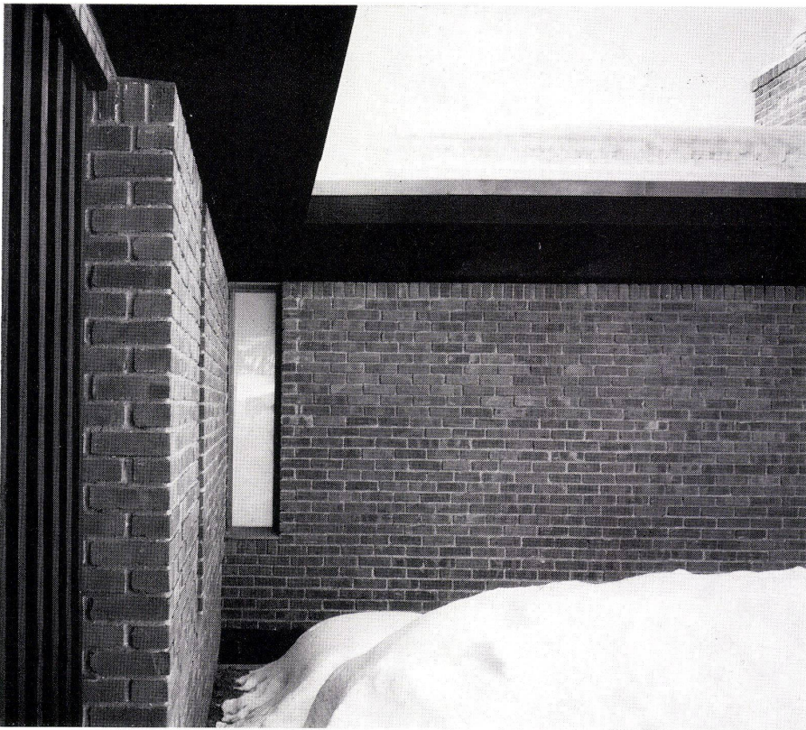
1 Blick entlang des Anbaues zur geschlossenen Rückwand. Links das Tor zur Garage. Vue lelong de l'annexe vers le mur arrière plein. A gauche la porte du garage. View along the annex toward the closed rear wall. Left, the garage door.
