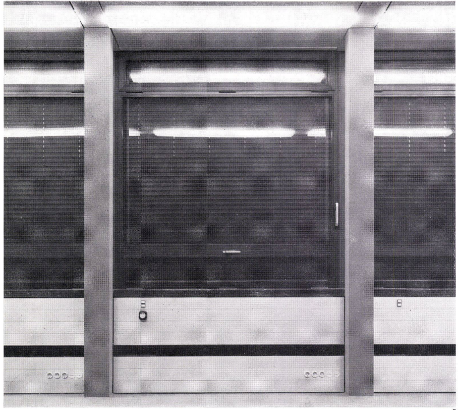
2 Fensterwandteil von innen gesehen. Festverglaste Mittelfenster mit oberem und unterem Lüftungsflügel im Brüstungsbereich die verkleideten Klimakonvektoren.
