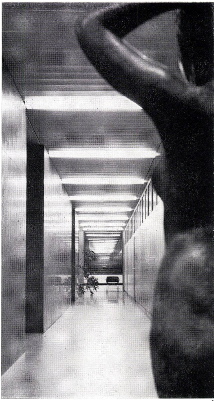
1 Ein Korridor in den Obergeschossen. Decke aus Metallamellen mit im Achsmaß versetzten Beleuchtungskörpern. Zwischenwände in Strafor-Hauserman-Wandelementen.
