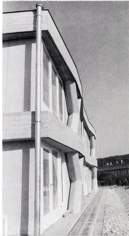
3 Pfarrhof, Schrägansicht, die die Form der Randträger deutlich zeigt. Presbytère vu obliquement, il montre exactement la forme des supports latéraux. Parsonage as seen from the angle, showing above all the shape of the border supports.
