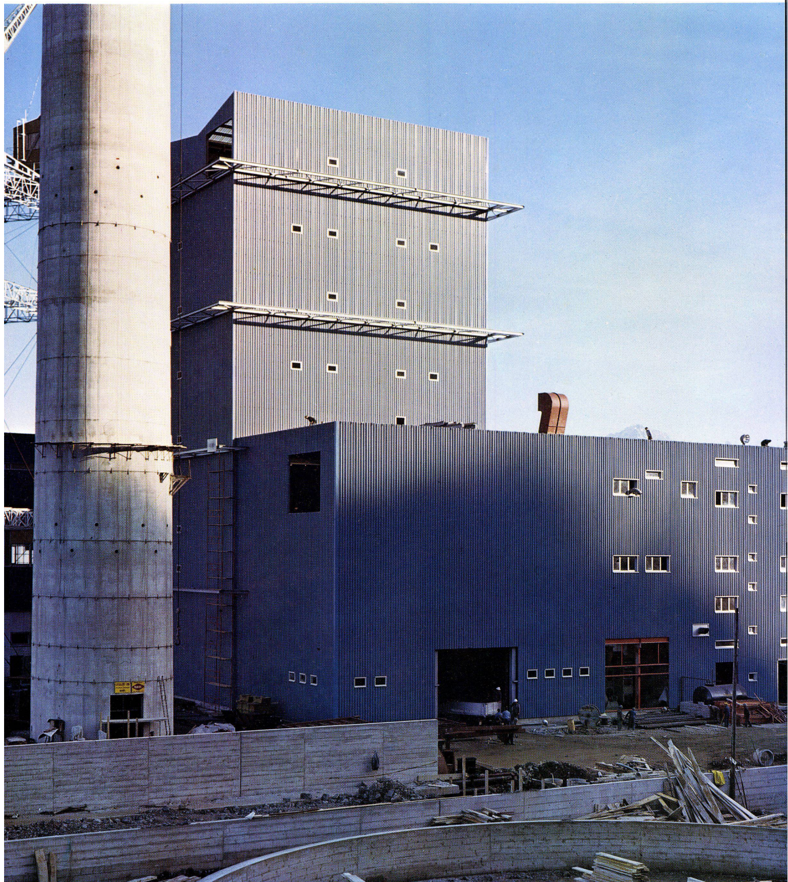
Thermische Kraftzentrale Vouvry mit gewellten Alucolux-Bändern verkleidet
