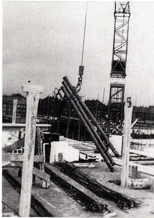
6 Fertigung großer Wandelemente im fliegenden Betrieb.
