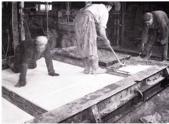
7 Zwischenschichtisolierung in einem Fertigbauhaus mit Schaumstoffplatten (Styropor, BASF)
