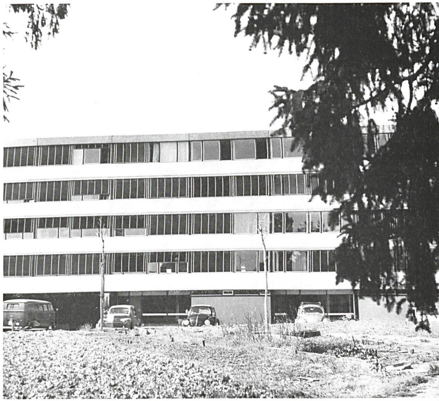
1 Fassadenausschnitt mit Südbalkonen. Détail de façade avec des balcons sud. Elevation detail showing south balconies.
