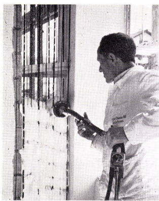
8 Schlitzisolierung – Griso-Spritzschaum wird durch Rippenstreckmetall gedrückt.
