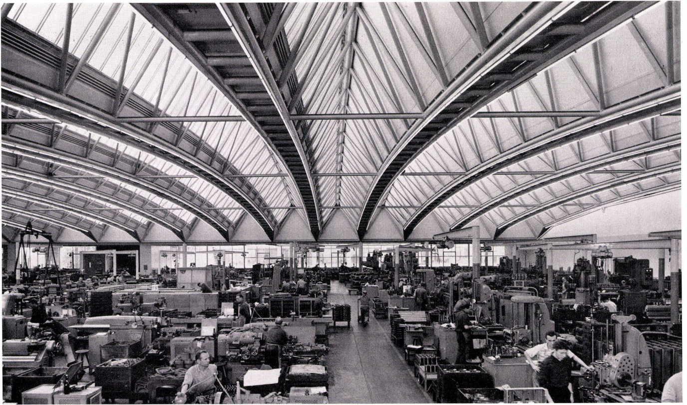
1 Fertigung im stützenfreien Obergeschoß des Flachbaus. Räumliche Stahlrohr-Fachwerkbinder, 60 m frei gespannt. Fabrication à l'étage supérieur du bâtiment plat sans piliers. Construction en triangle de tubulaire 60 m portée. Finishing in pillar-free upper storey of flat building. Tabular steel latticework in space, 60 m. free span.
