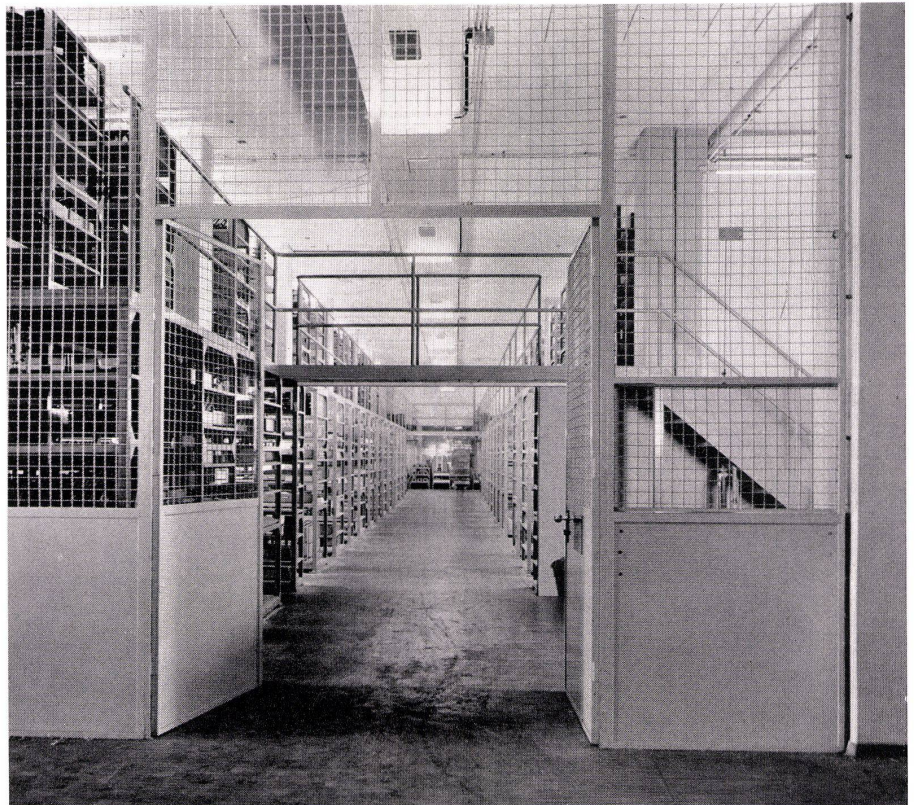
3 Lager im Erdgeschoß des Flachbaus. Kopflose Stahlbetonpilzdecke. Magasins au rez-de-chaussée du bâtiment plat. Dalle-champignon. Stores on ground floor of flat building. Headless reinforced concrete mushroom ceiling.
