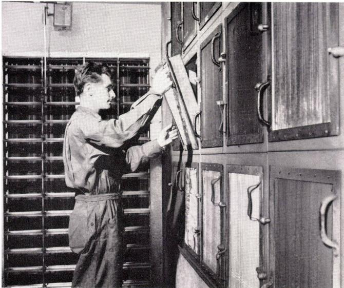
Der Sulzer Service-Mann wechselt in bestimmten Zeitabständen die Luftfilter in den Klima- und Lüftungsanlagen aus.
