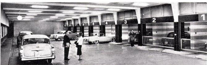
Der vollautomatische Autosilo, der erste der Welt, enthält umfangreiche und komplizierte technische Einrichtungen (Fernsteuerungsteil von Siemens & Halske und fördertechnischer Teil von Mohr & Federhaff, Mannheim).
