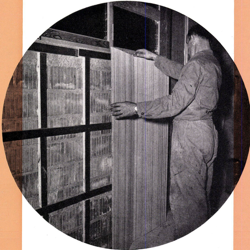
Fig. 1 Verlegen von Laril-Rillentäferplatten auf Lattenrost
