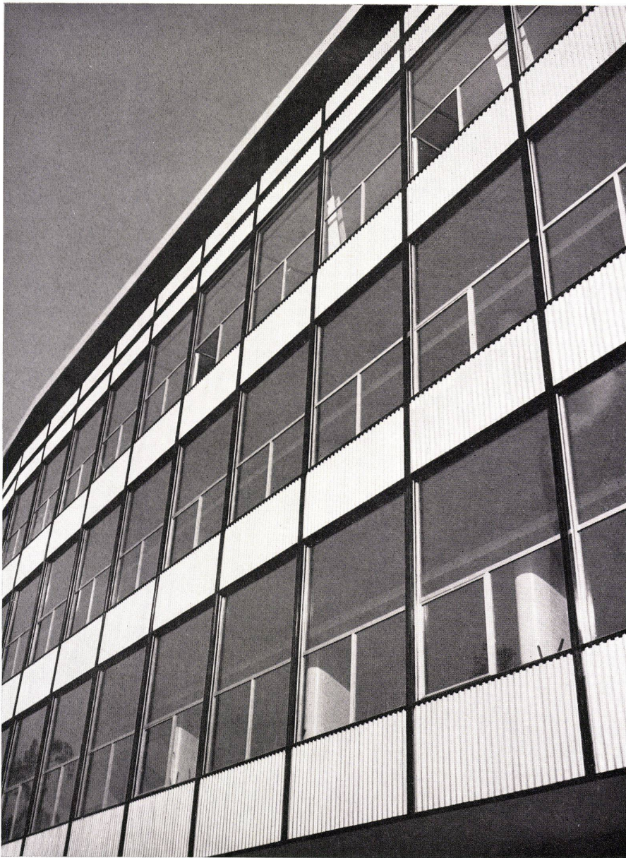
1 Fassadendetail. Brüstung aus farbig eloxiertem Peraluman.
