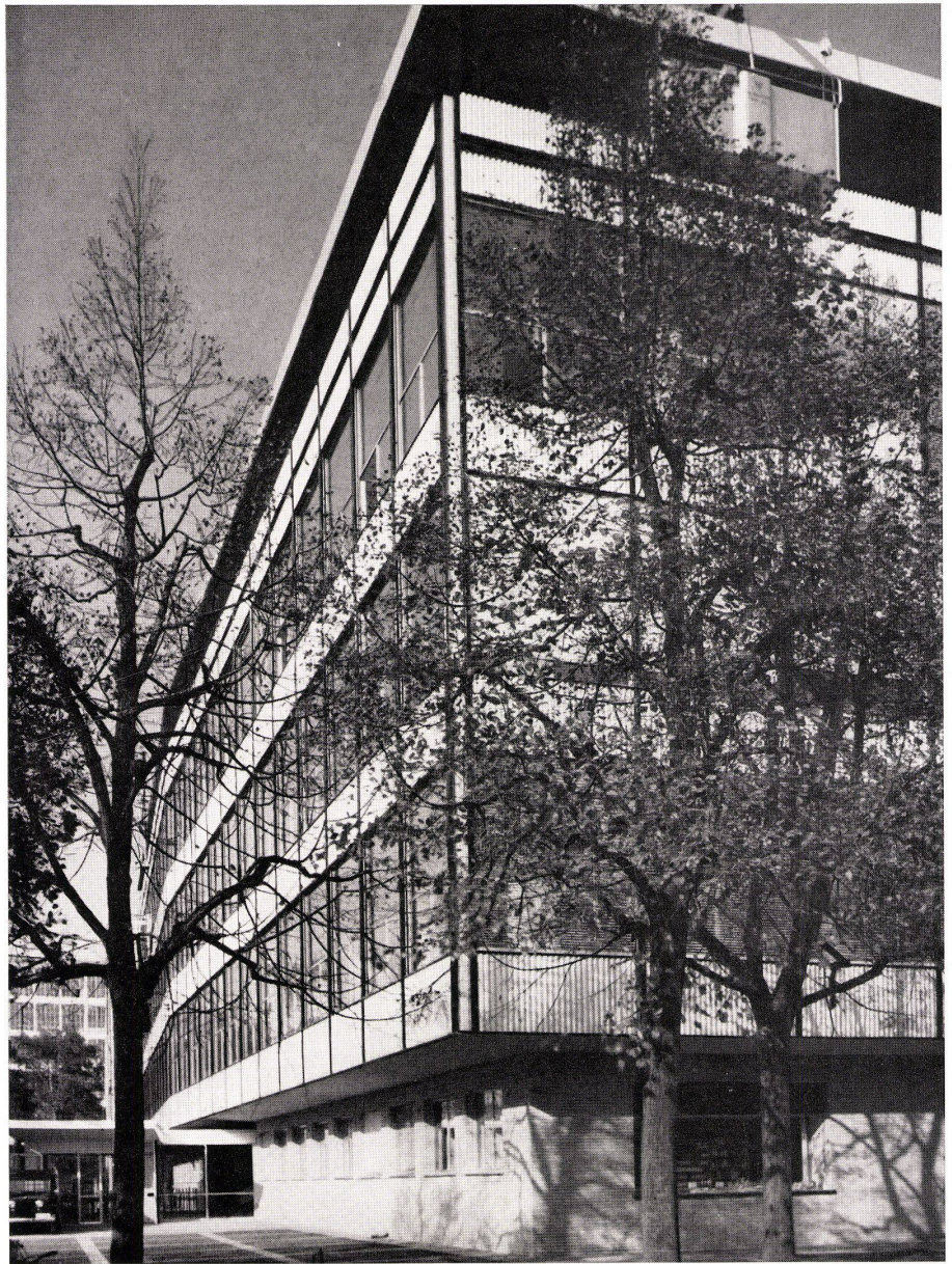
Eckansicht. Vue d'un coin. Corner view.
