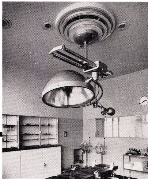
Klimaanlage «System Häusler» in Operationssaal eines Spitals
