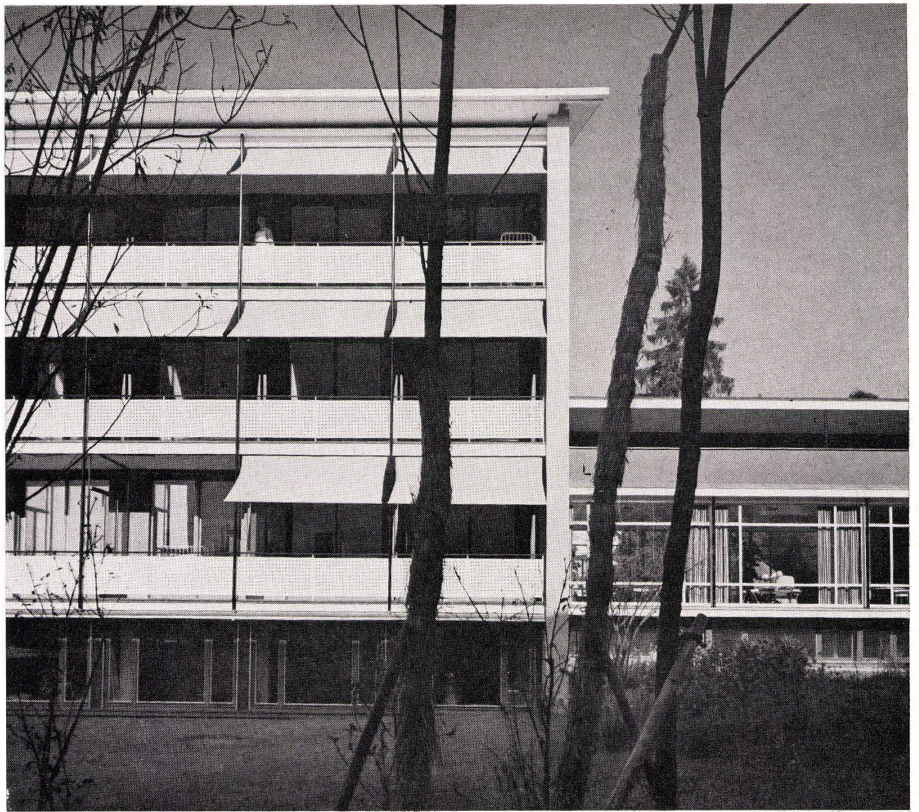
Detail Südfront mit Blick auf Eingangshalle. Détail façade sud et vue sur le hall d'entrée. Detail of south elevation with view of entrance hall.
