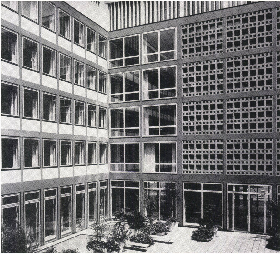
1 Innenhof. Hinter den Fertigbetonkassetten die Toiletten- und Garderobenräume, daneben Treppenhausfenster. Cour intérieure. Interior court.
