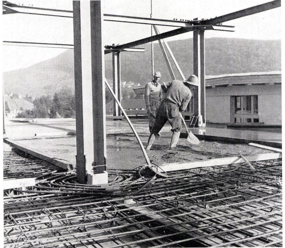
3 Deckenarmierung. Armure du plafond. Ceiling reinforcement.
