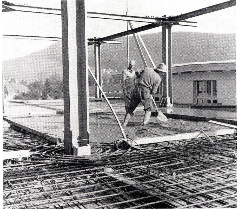
3 Deckenarmierung. Armure du plafond. Ceiling reinforcement.
