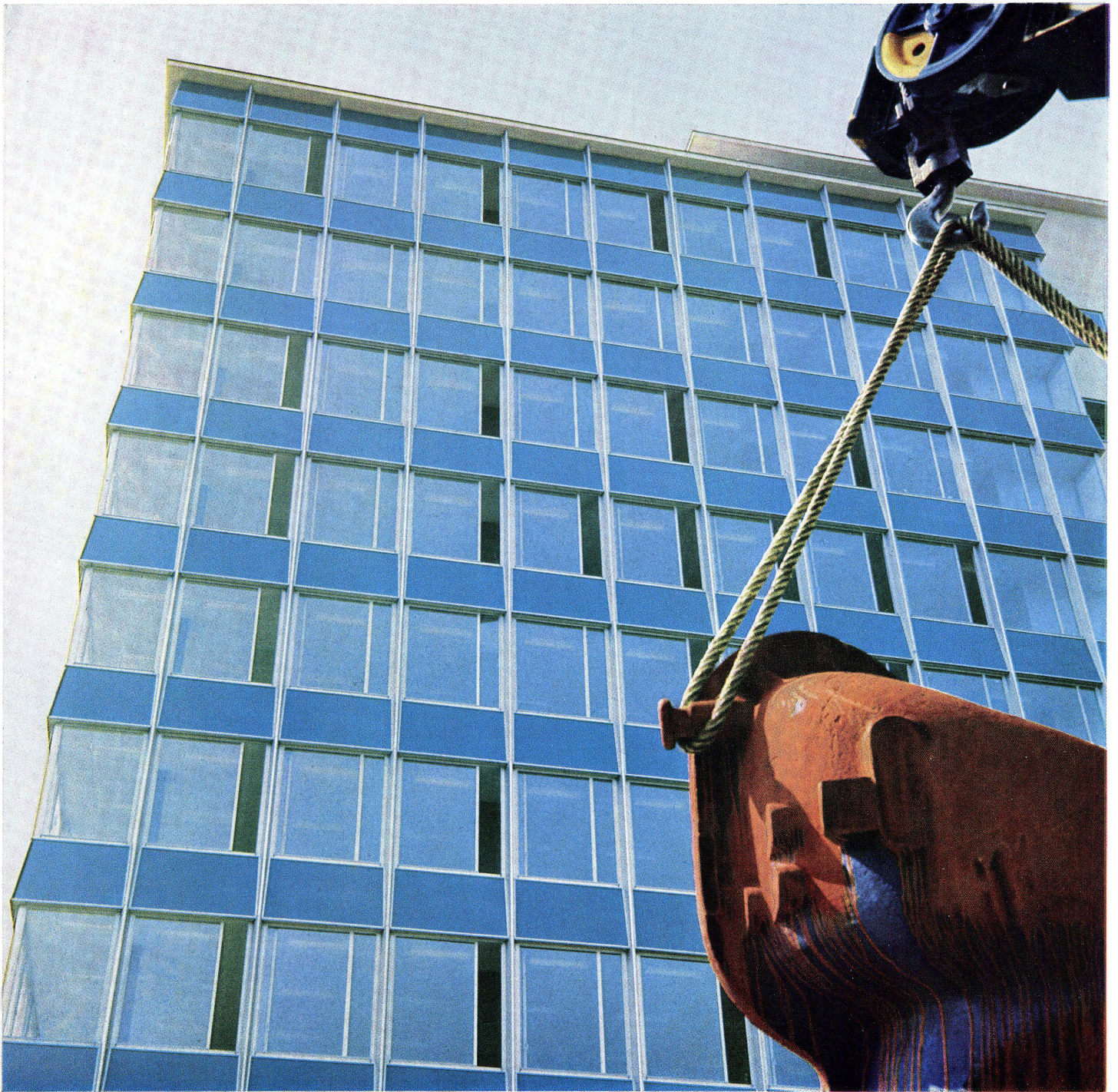
Bürohaus BBC Baden mit unserem Fenstermodell 700 ausgeführt, in Arbeitsgemeinschaft mit Gebrüder Tuchschnid AG, Frauenfeld
