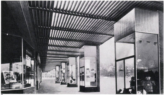
1 Tramwarte Halle an der Schweizerischen Mustermesse in Basel in Shadelite-Konstruktion. Aus dem Bild ist die Lichtdurchlässigkeit der Konstruktion gut ersichtlich.
