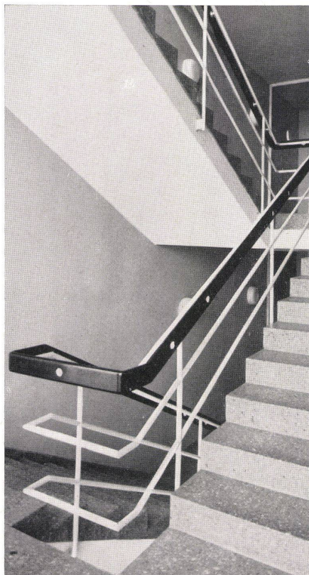
Treppenhaus. Cage d'escalier. Staircase.
