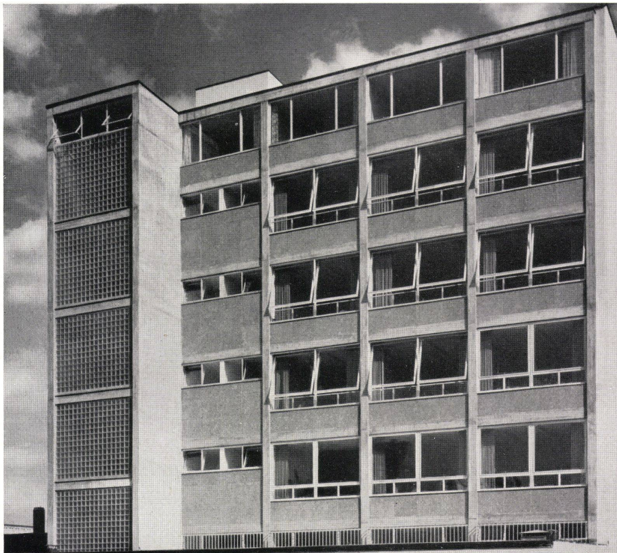
Rückansicht. Skelett in Sichtbeton, Brüstungen Ziegeltrümmersplittplatten. Fenster in Stahl. Vue de derrière. Squelette en béton nu, appuis, en plaques faites de briques concassées. Fenêtres en acier. Rear view. Skeleton in unrendered concrete, parapets of brick chip sheets. Steel-framed window.
