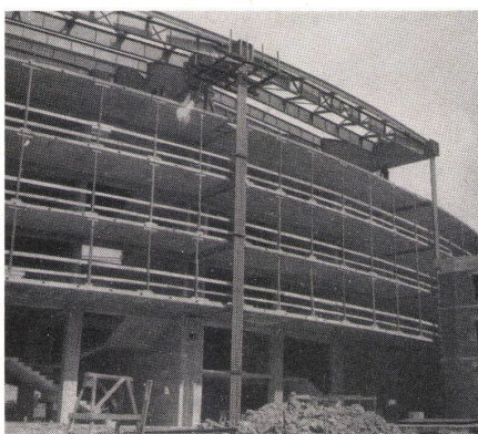
Stahlzuganker der Stahlbinder an der Außenfront. Tirant en acier des fermes à l'extérieur du stade. Steel tie rod of the steel trusses at the outside of the front wall.
