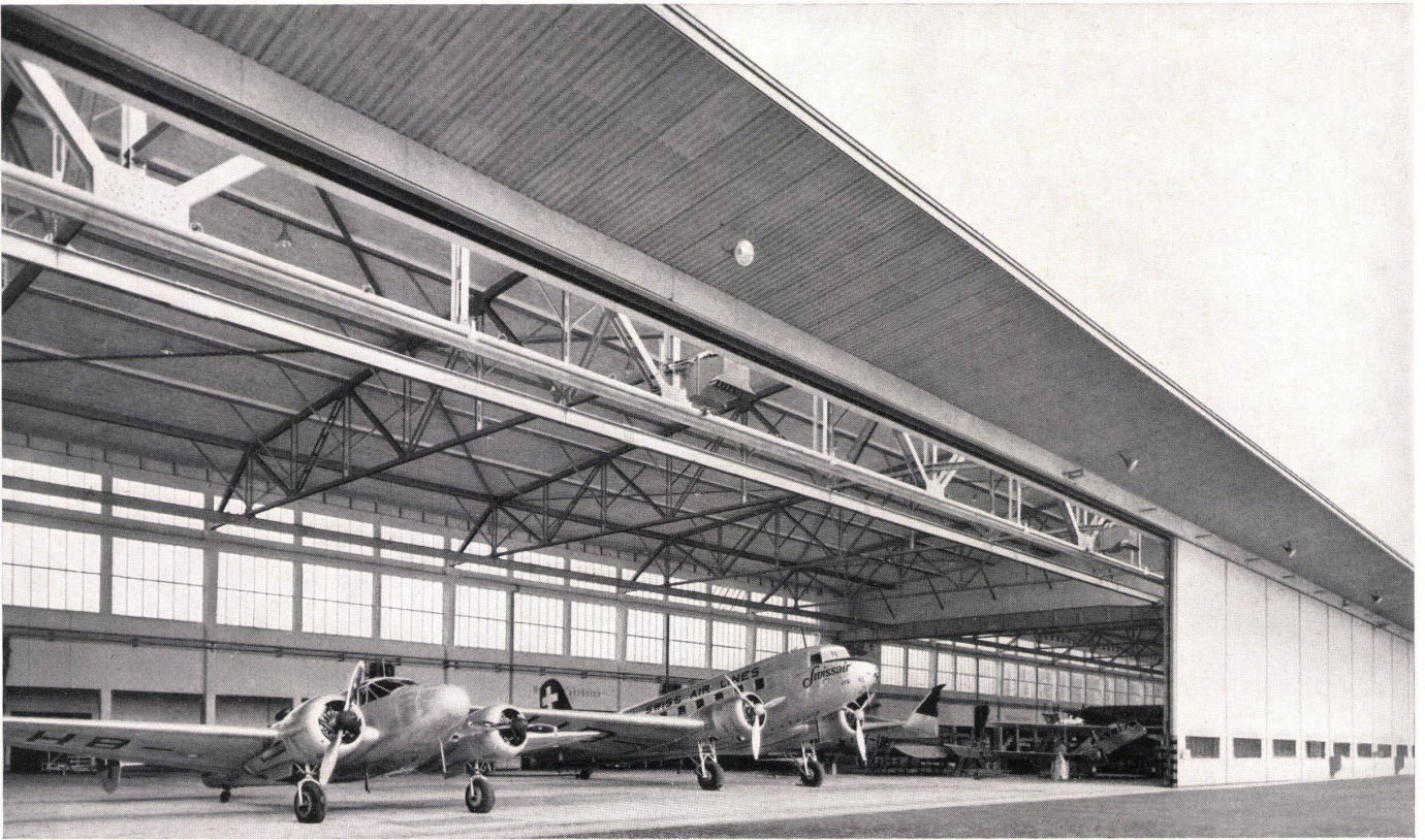
Kloten/Zürich Werfthalle. Salle de construction. Workshop.
