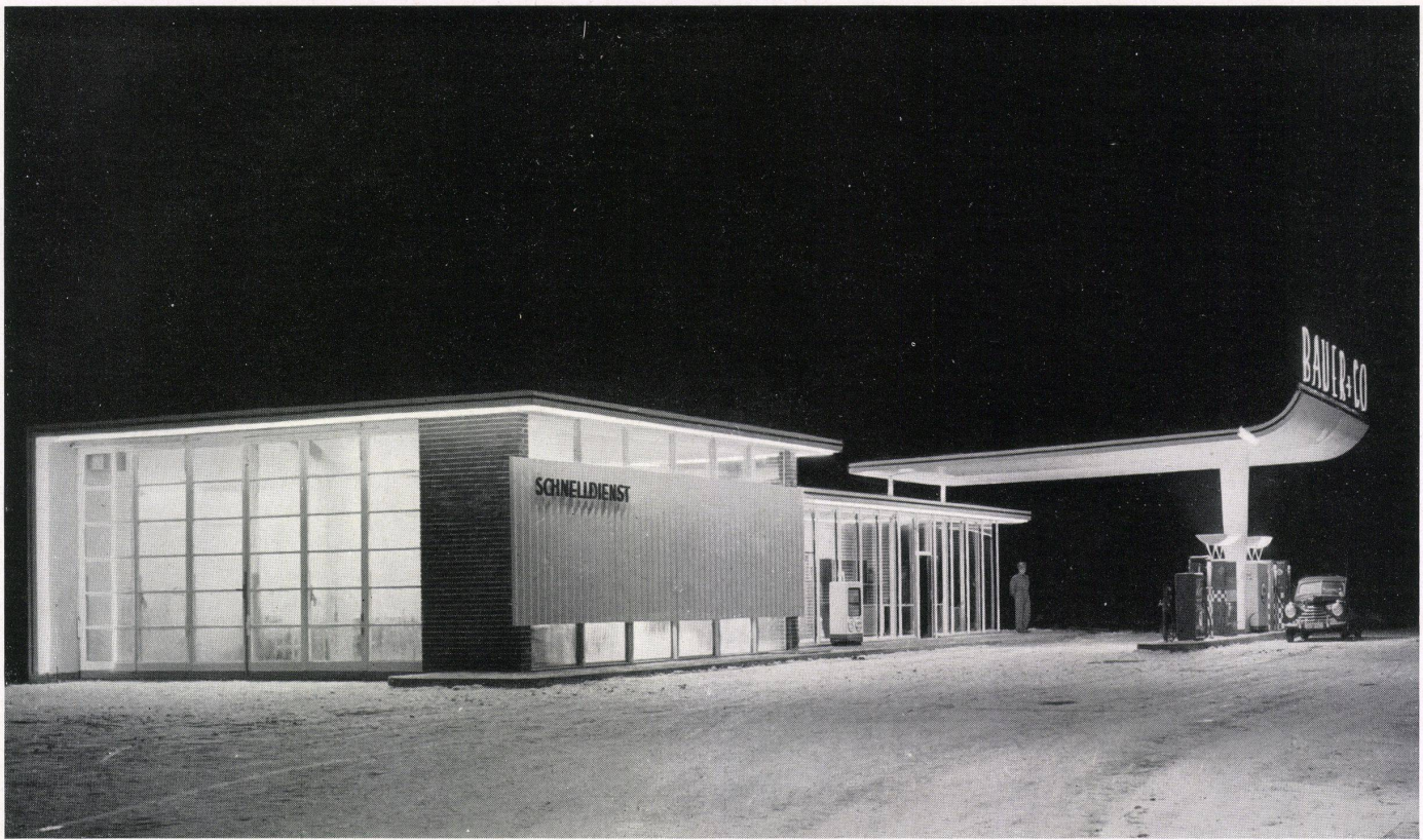
Westansicht mit Abschmier- und Duschhalle. Vue prise de l'ouest avec salles de graissage et de nettoyage. View from the west with greasing and washing-down hall.
