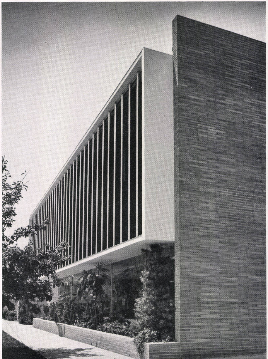
Ansicht der Straßenfassade von Nordosten. Starker Materialgegensatz zwischen Leichtbetonmauern, Sichtbetonteilen und Aluminiumlamellen. Vue de la façade donnant sur la rue, prise du nord-est. View of the street facade from the north-east.
