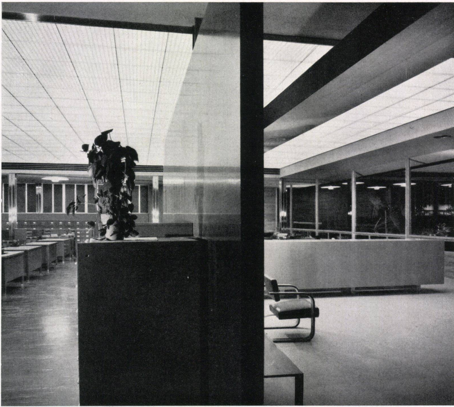
Blick in die Bürohalle mit den Pulten. Die ganze Decke ist als Beleuchtungsfläche ausgebildet: Lichtraster mit darüber angeordneten Fluoreszenzröhren. Rechts Blick in den Publikumsvorraum mit der Auskunft.
