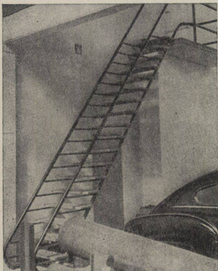
Treppe / Escalier / Staircase
