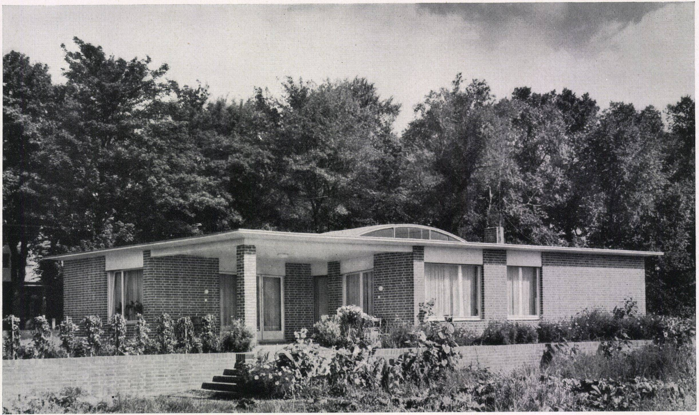
Ansicht des Wohnhauses vom Garten (Südwestseite). Vue prise du jardin (sud-ouest). View of the house from the garden (south-west side).
