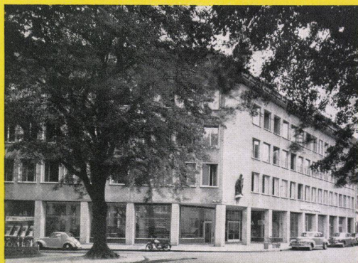
Schweiz: Büro- und Geschäftshaus, Zürich
