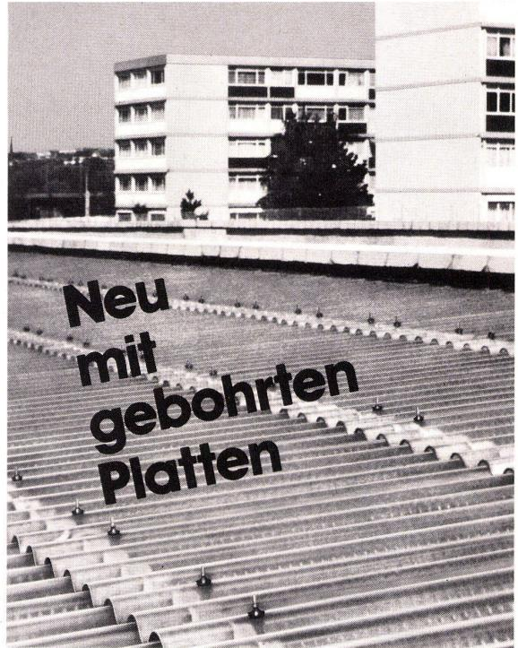
Wellglasplatten aus Drahtglas (passend auf grosswellige Asbestzementplatten, Marke ETERNIT).
