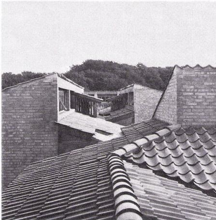
Ein wichtiges Anliegen der Architekten bestand darin, im Bereich des Verbindungsganges die nach beiden Seiten gerichteten Pflegeeinheiten mit ihren schrägen Dachflächen miteinander zu verzahnen, um so die stereotype Lösung des flach eingedeckten Zwischenbaus zu vermeiden.
